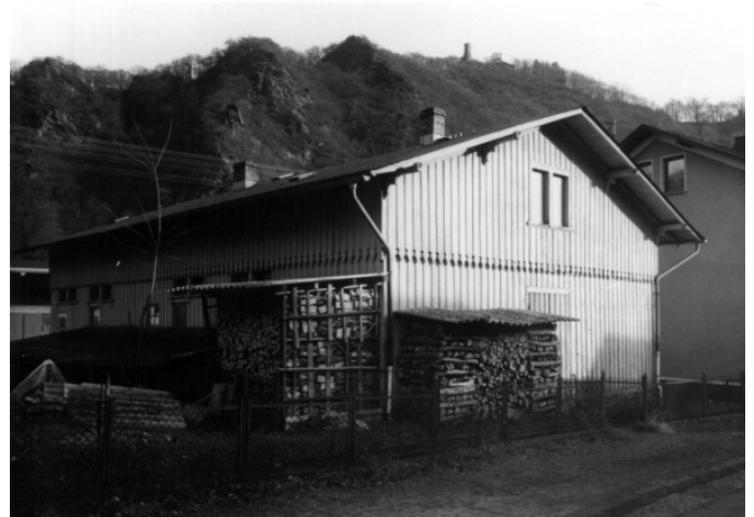
Die alte Bahnhofhalle noch im Dienste der Bahnmeisterei an ihrem ursprünglichen Standort am Hauptbahnhof Bad Ems. Schon 1991 machte das Gebäude einen Umzug in die Arzbacher Straße mit. Foto: Frank Girmann
